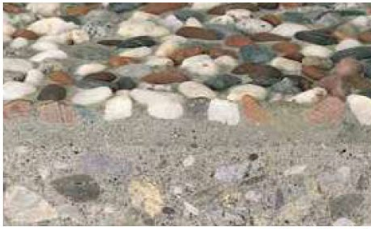
※ペイブストーン施工部分
