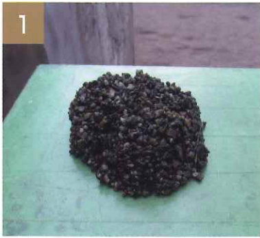
①練り上げた骨材をコテ板に乗せます。
