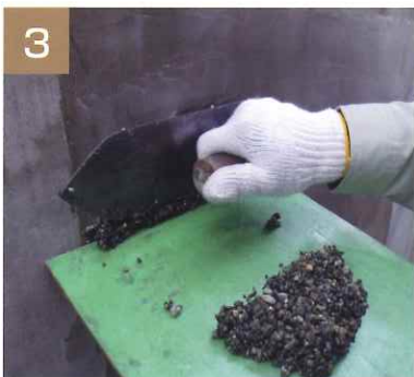
③力を入れてコテを下から真っ直ぐ上へ押し付けるように塗ります。
