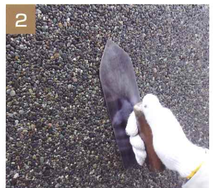
②力を入れてコテ圧をかけ、しっかり押さえて骨材を密に仕上げます。 「3. 骨材塗りつけ」で塗った範囲ごとに骨材の伏せ込みを行ないます。
