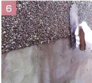
⑥ある程度の列(範囲)で塗り付けましたら、列同士がなじむように均します。
