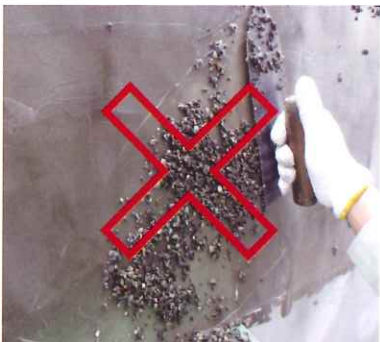
モルタルを塗るように、はじめから扇状には塗れませんのでご注意ください!!
