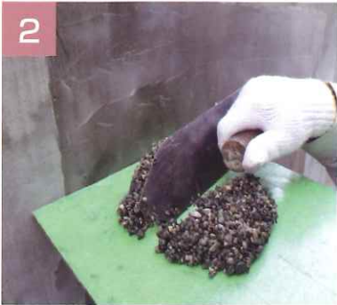
②コテ板を下地に押し付けます。
