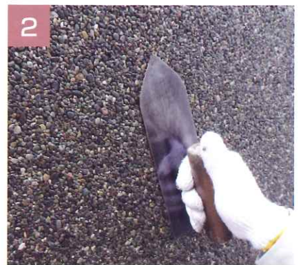
②力を入れてコテ圧をかけ、しっかり押さえて骨材を密に仕上げます。 「3. 骨材塗りつけ」で塗った範囲ごとに骨材の伏せ込みを行ないます。
