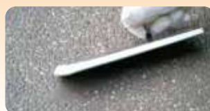
目詰め材の かき出し
