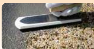
目詰め材の 流し込み
