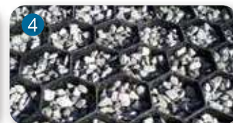
充填完了 充填後各種化粧砂利を敷きこんでください
