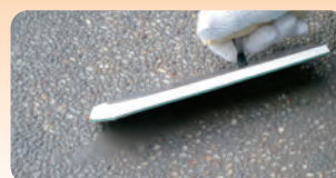
目詰め材のかき出し
