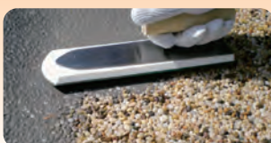
目詰め材の流し込み
